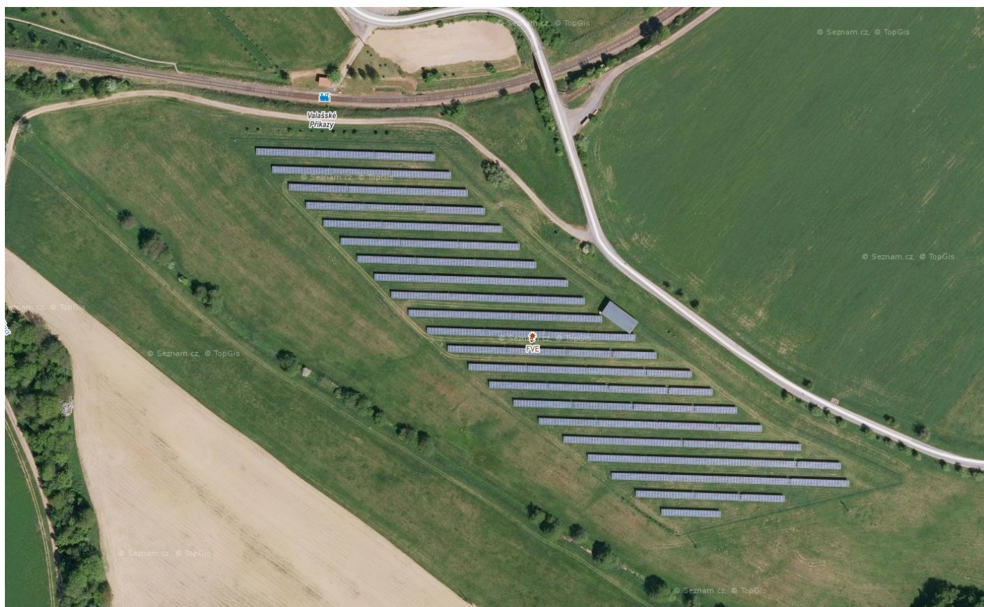
Obr. 4: Fotovoltaická elektrárna na území obce Valašské Příkazy
